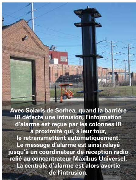
Avec Solaris de Sorhea, quand la barrière IR détecte une intrusion, l'information d'alarme est reçue par les colonnes IR à proximité qui, à leur tour, le retransmettent automatiquement. Le message d'alarme est ainsi relayé jusqu'à un coordinateur de réception radio relié au concentrateur Maxibus Universel. La centrale d'alarme est alors avertie de l'intrusion.
